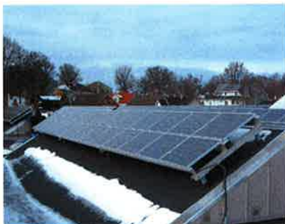
Kungsmadskolan, Växjö. Foto: Energibanken
