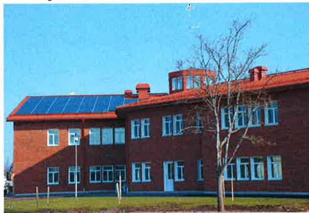
Vargbroskolan med dess 131 m 2 stora solcellsanläggning på taket
